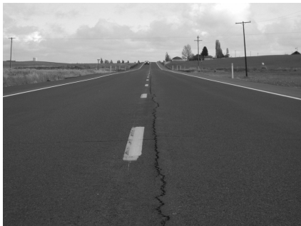
Longitudinal Cracking
